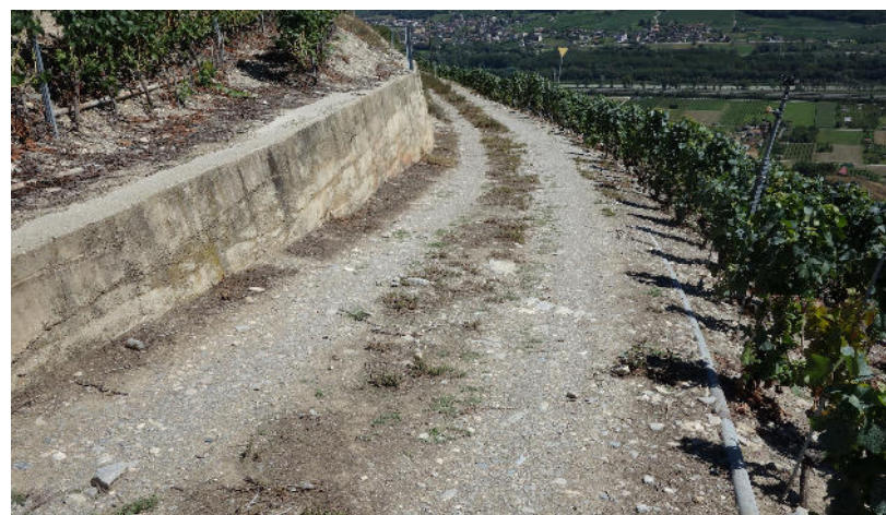
9 Ordnung muss sein: Beidseitig abgespritzte Wegbankette. Auch für einen sauberen Mittelstreifen hat ein Rest im Spritzgerät noch ausgereicht. Abgespritzte Wegbankette sind im Walliser Rebbau ebenso die Regel wie gesetzeswidrig.
